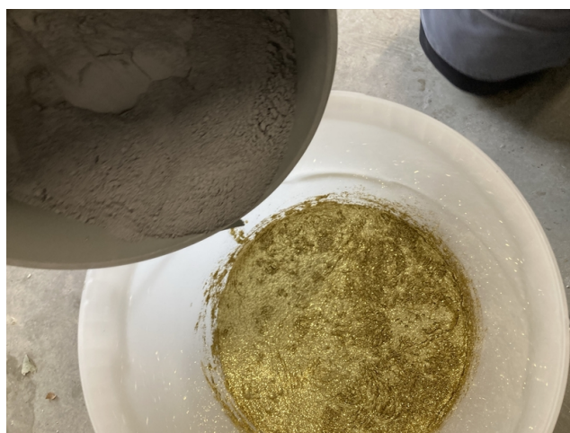
De voegmortel wordt aan het met glitter gemengde aanmaakwater toegevoegd.
