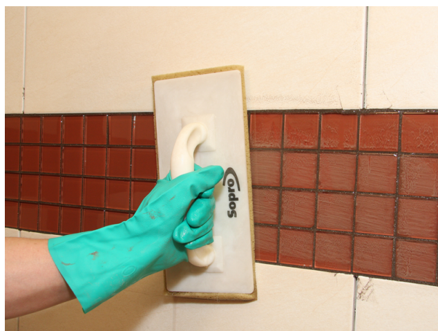
Afwassen van glasmozaïek na voldoende standtijd van de voegmortel.
