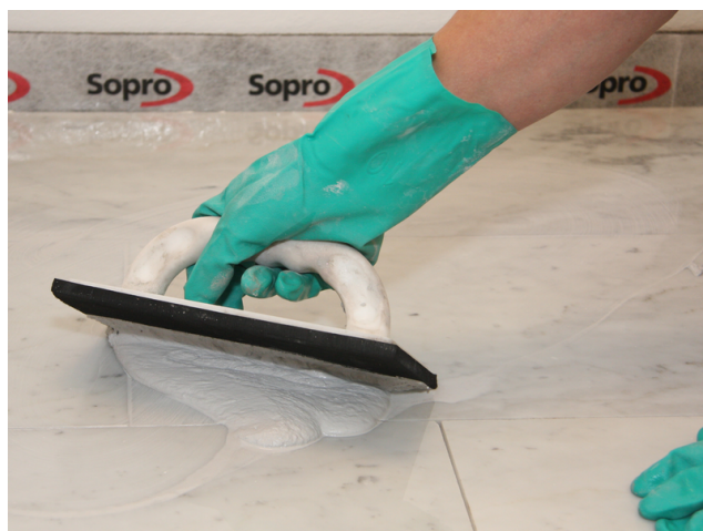
Voegen van Sopro DF 10 in verkleuringsongevoelig natuursteen.
